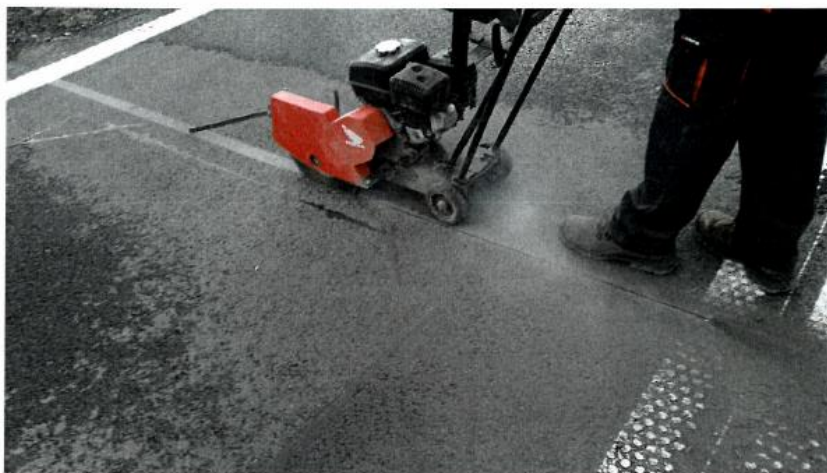
Rysunek 3 Wycinanie rowków na sensory wagowe
